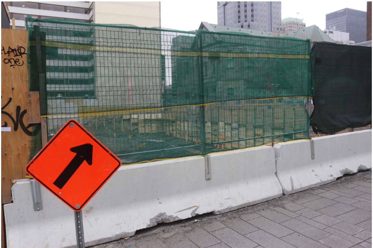
Le chantier des condominiums Maestria vu depuis la rue Sainte-Catherine.
